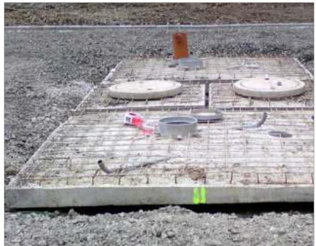
Das Beispiel zeigt die auf die Basisbehälter gelegten teilbetonierten Bodenplatten mit zusätzlichen Regenwasserzisternen. Zwei mal GOLDGRUBE®/BB-Bt, für ein Toilettenhaus mit zwei barrierefreien Toilettenräumen + schmaler Technikraum.
