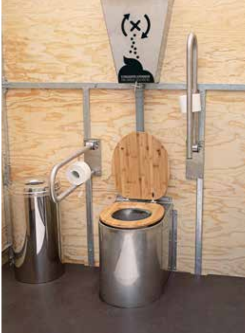
Die öffentliche Trockentoilette „Libre“ von Finizio steht in Eberswalde, hat eine Streuspülung, ist barrierefrei und braucht keinen Zuwasser-, Abwasser- oder Stromanschluss.
