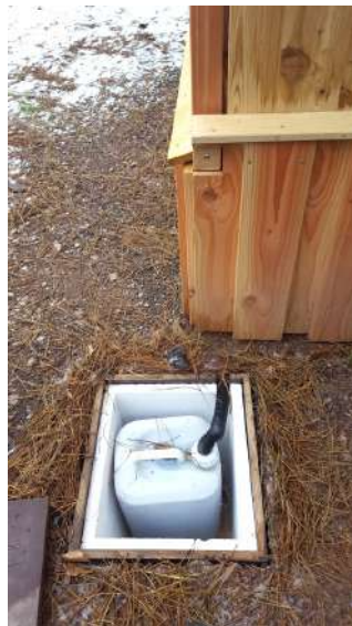
Der Sickerwasserkanister ist unterhalb der Biolan eco vertieft.
