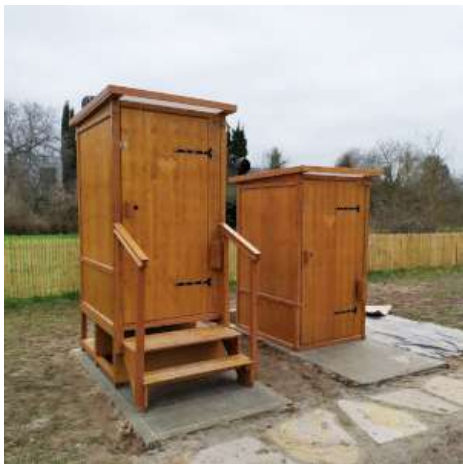
Toiletten WIESE Sondermasse, beide mit Biolan eco. Bei der Toilette für die Kinder wurde die Biolan vertieft, damit die Toilettenkabine ebenerdig ist.
