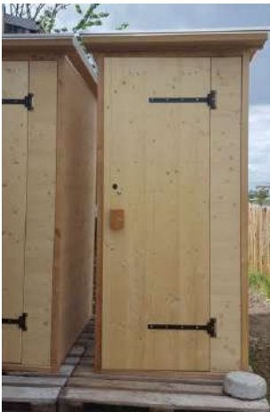
Öffnung der Tür (72 cm breit) links von Außen.
